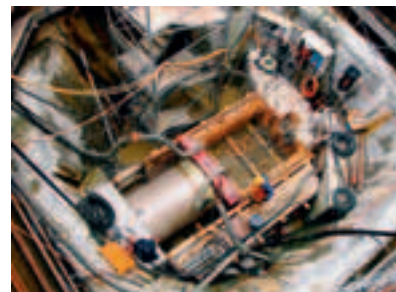
En 2005, quelques projets intéressants ont été réalisés dans le microtunnelling, p. ex sur le chantier près du tunnel «Les Vignes».
